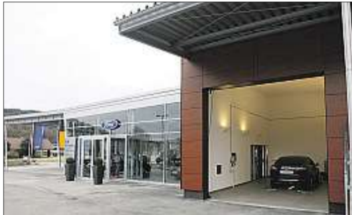
Der Neubau ist umweltgerecht konzipiert. Zahlreiche Handwerker aus dem Lorcher Raum waren daran beteiligt.
